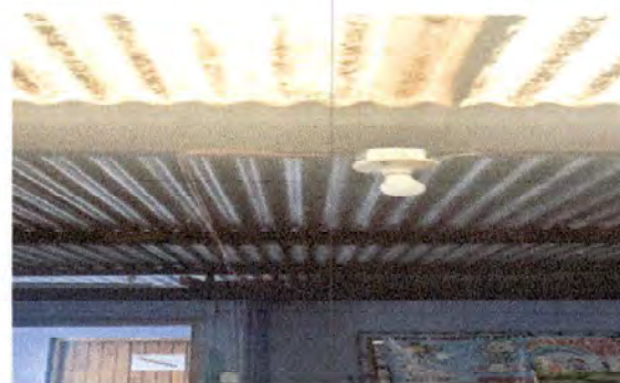
Modulo 1. Reparacion del sistema electrico.
