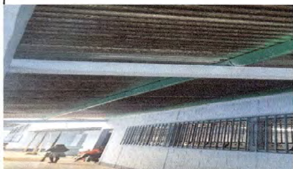
Modulo 2. Mantenimiento de estructura de soporte de metal
