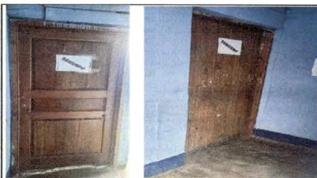
Modulo 1 sustitucion de puertas.
