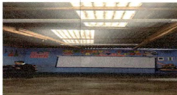
modulo 1. Sustitucion de lamina por lamina troquelada Aluzinc calibre 26
