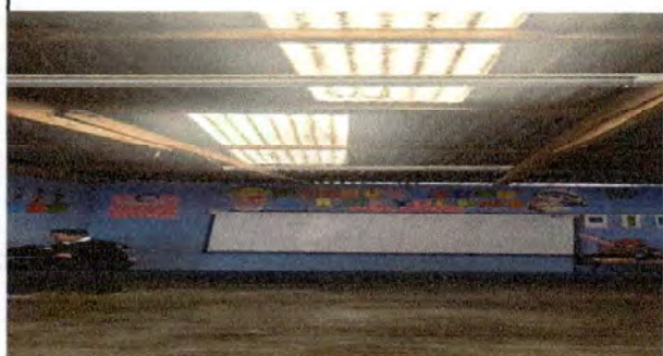
Modulo 1. Sustitución de estructura de soporte de madera por metal
