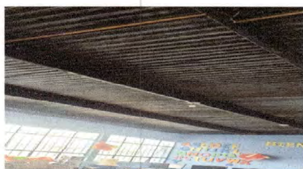
Modulo 2: Sustitucion de lamina por lamina troquelada aluzinc 26
